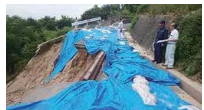
岡山、広島で豪雨災害の現地調査
