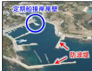
離島の定期船発着岸壁や防波堤の防災対策
