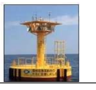
海域環境観測施設
