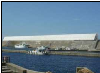
防波堤嵩上げによる越波防止
