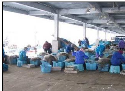
屋根施設の整備による作業環境の向上
