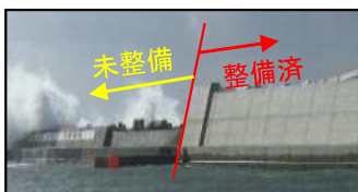
防波堤整備による越波防止
