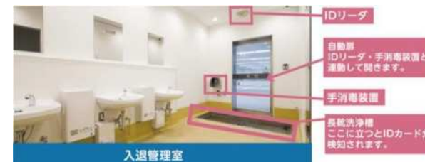
入退場管理室 IDリーダー 自動扉 IDリーダー・手消毒装置と連動して開きます。 手消毒装置 長柄洗浄槽 ここに立つとIDカードが検知されます。 サニタリー入場 → 手洗い・長柄洗浄 → 荷部場へ入場 荷さばき所における人の入退場管理
