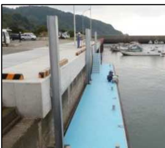
浮体式係船岸の整備による漁労作業の軽労化
