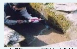
水路のひび割れ補修
