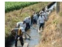
水路の泥上げ
