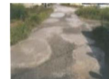
農道の窪みの補修
