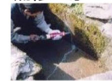
水路のひび割れ補修
