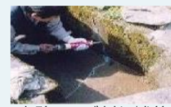
水路のひび割れ補修
