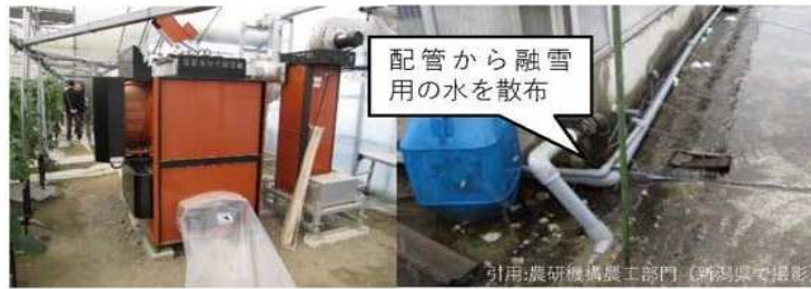
融雪装置 (加温機等) の設置
