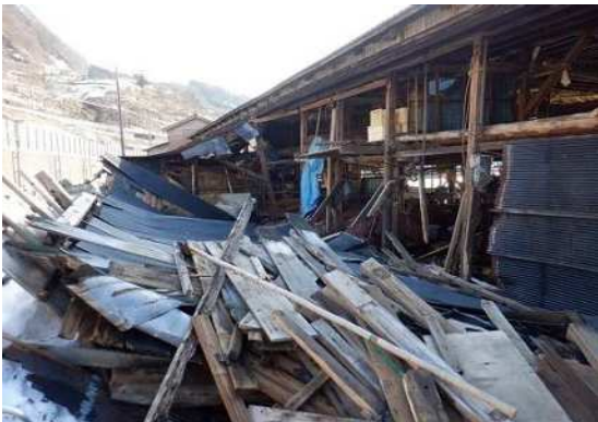
屋根や柱が倒壊した船小屋
