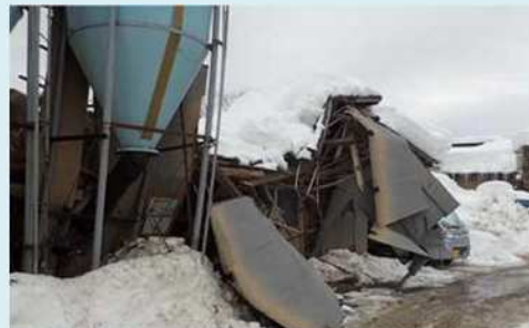
・積雪による牛舎の倒壊
