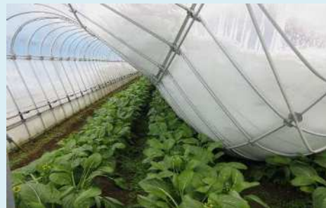
・積雪により倒壊したハウス内
