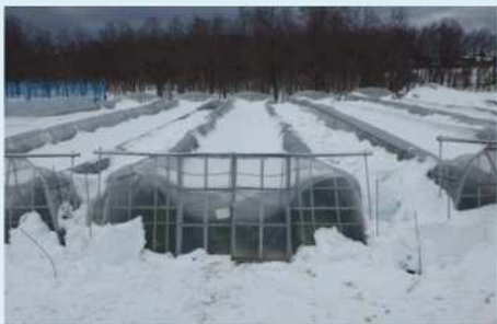
・積雪により倒壊したハウス
