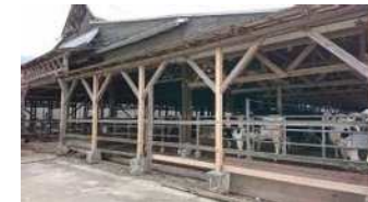
牛舎の補改修
