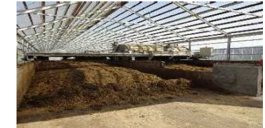
堆肥舎の補改修
