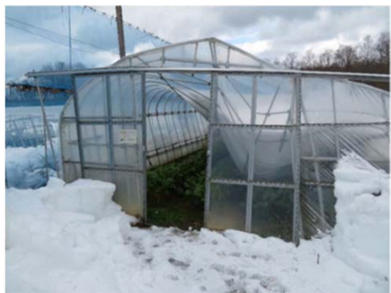
《被災した育苗ハウス》
