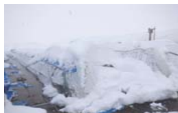
被災した特用林産振興施設
