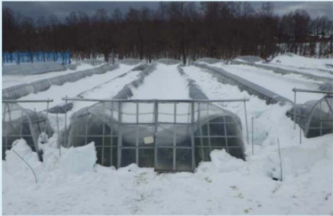
・積雪により倒壊したハウス
