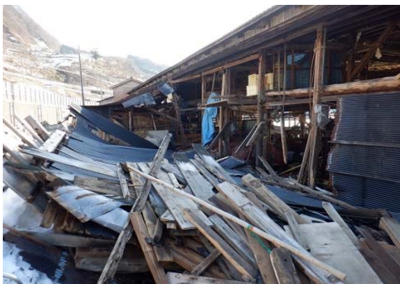
屋根や柱が倒壊した船小屋
