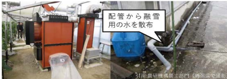
融雪装置(加温機等)の設置
