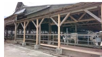
牛舎の補改修
