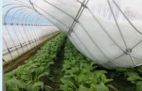
・積雪により倒壊したハウス内
