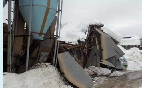
・積雪による牛舎の倒壊
