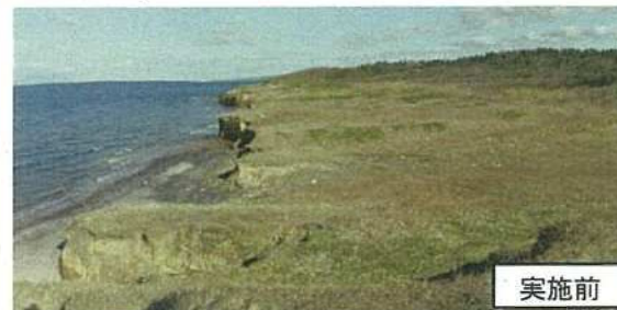
防潮工の整備 (波浪による侵食等の防止)
