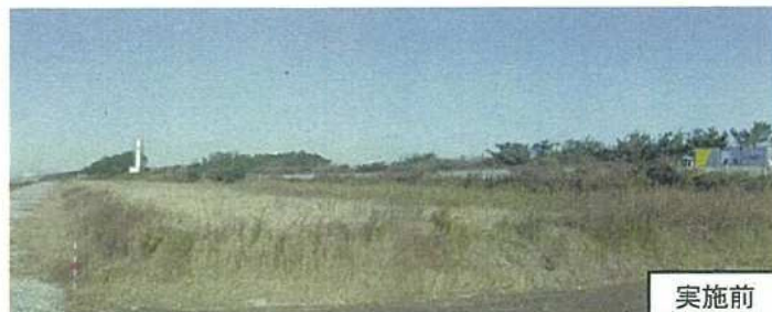
海岸防災林の整備 (植栽工の実施)
