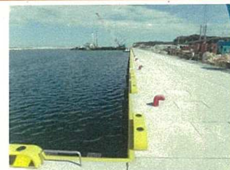
岸壁の耐震強化
