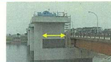
耐震不足が生じている箇所を補強 (堰柱の巻立)
