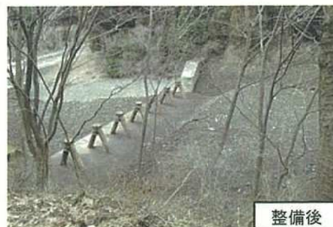
流木捕捉式治山ダムの設置
